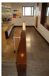
8. Rampa sala infantil
